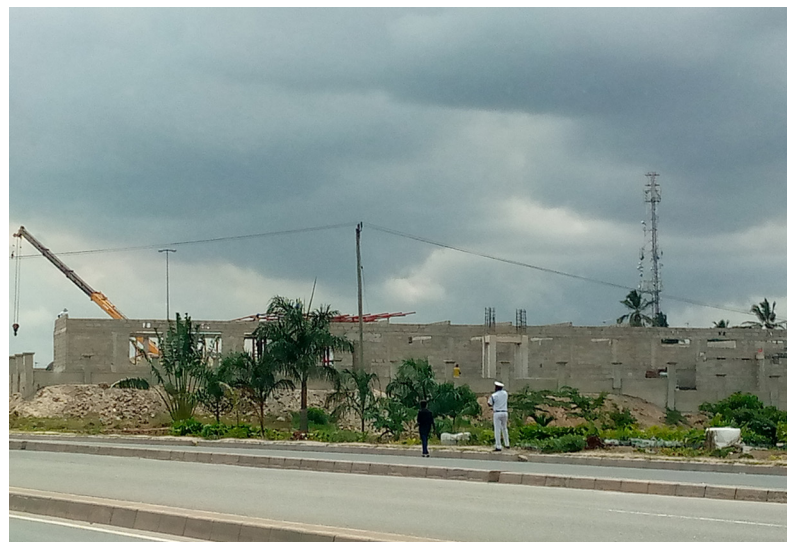
Ujenzi wa kituo cha mafuta ukiendelea katika hifadhi ya Barabara ya Morogoro, eneo la Kimara Temboni, Dar es Salaam.
